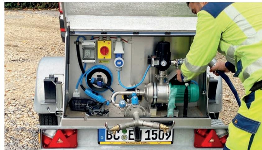
Mitarbeiter Arslan Abdülhamit beim Spülen eines Endhydranten und beim Aufbau einer Notversorgung mithilfe eines Wasserwagens.
