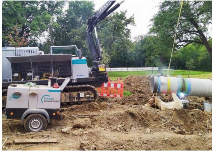
Einbringen der vorgestreckten Zubringerwasserleitung in den Rohrgraben
