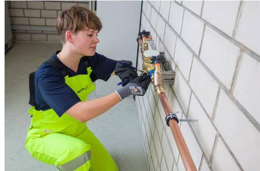
In der Ausbildung sammeln die Auszubildenden wertvolle Praxiserfahrung bei typischen Tätigkeiten der Wasserversorgung – von der Installation von Zählern bis zum Umgang mit technischen Armaturen.
