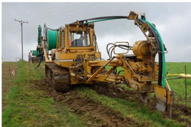
Beim Fahren mit dem Kabelpflug schneidet ein spitz zulaufendes Pflugschwert den Boden in einer minimalen Breite und der nötigen Tiefe auf. Die Stromkabel und Leerrohre, die je nach Pflugtyp vorne oder hinten mitgeführt werden, gleiten in den geschaffenen Erdschlitz. Durch die geringe Breite des Schlitzes fällt das Erdreich, nach dem Durchziehen des Pflugschwertes, fast von alleine wieder über die Stromkabel und Leerrohre.
