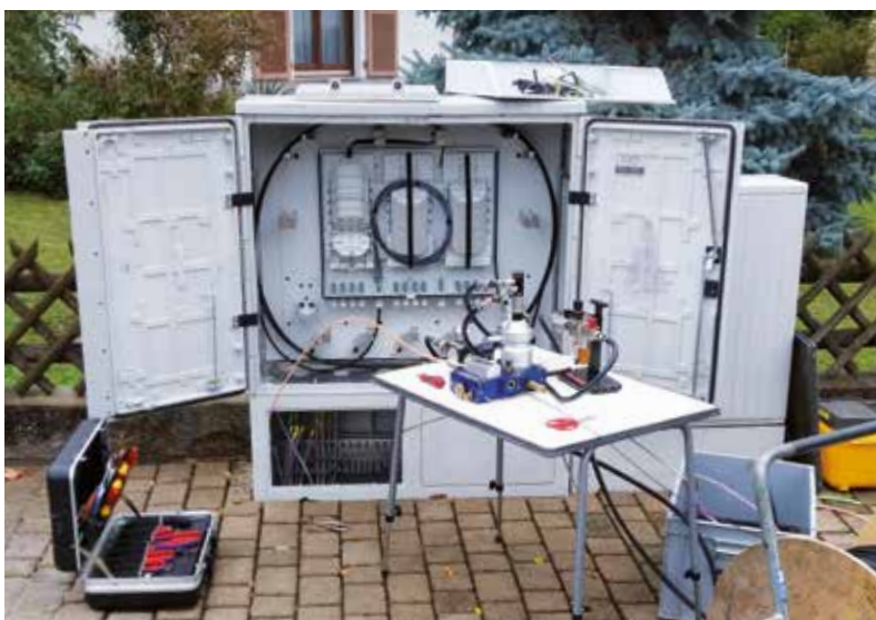
Glasfaserkabel werden mit Druckluft eingeblasen.
