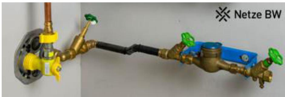
Abbildung 3: Die Mehrspartenhauseinführung
