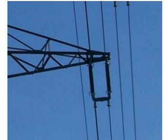
Verstärkungsmaßnahme: Beseilung eines Stromkreises mit 2er-Bündel Seiltyp 264-AL1/34-ST1A (Standardseil der Netze BW) und Erneuerung des Erdseils sowie LWL-Verbindung bis Mast 80 (kommerzielle Nutzung nicht beabsichtigt)
