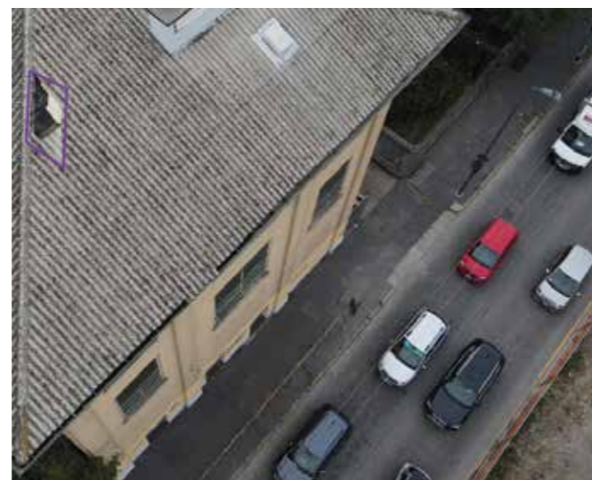
In alto , Ispezione aerea e termografia tramite droni per il rilevamento automatico di anomalie negli impianti fotovoltaici. In basso , Verifica dello stato di manutenzione delle coperture degli edifici tramite ispezione aerea con droni per il rilevamento e la classificazione automatica delle anomalie.
