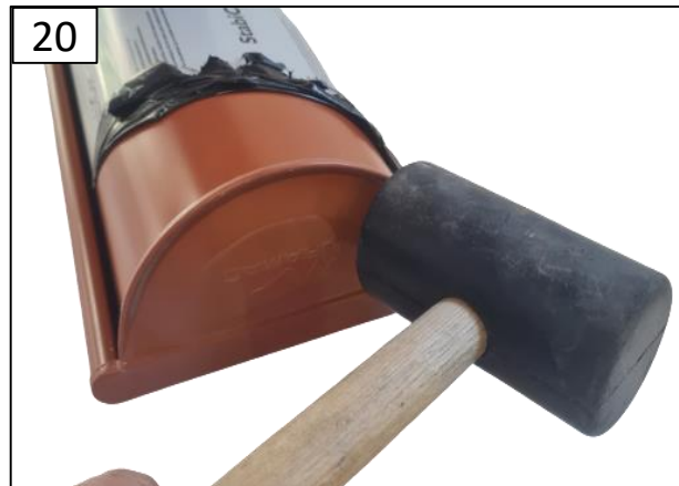
20 Nasadené ukončenie priklepať do pripraveného lemovania na žľabe
