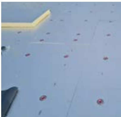
Realizácia kotvenia indukčného kotvenia Isoweld®
