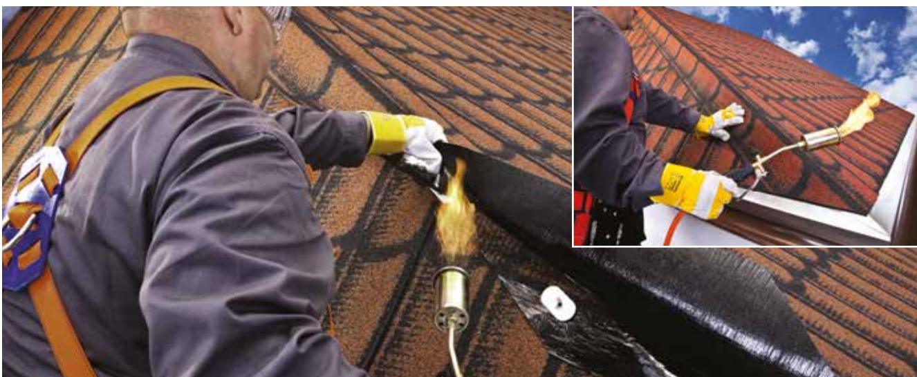
Pohledové opracování hřebene a nároží střechy s využitím vzoru na pásu
