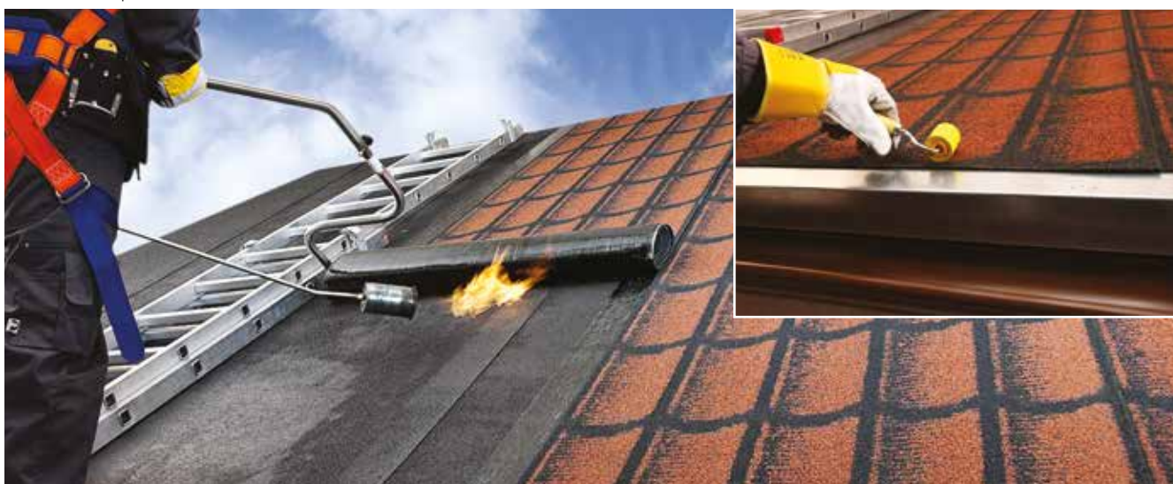
Natavování pásu RDI 3D na šikmou střechu
