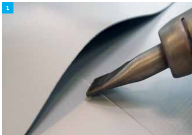
Obr. 15: Kontrola svaru izolačnou jehlou
