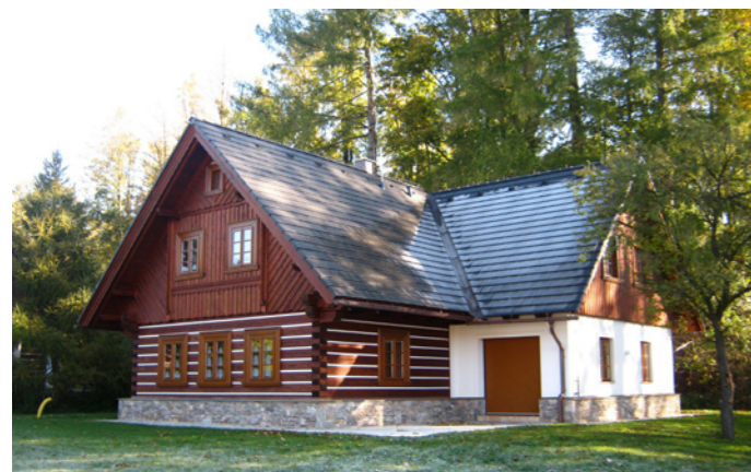
Moderní roubenky jsou poloroubené stavby - roubení se umísťuje na podezdívku
