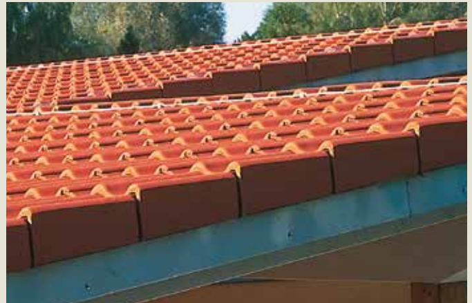
12. Položenie krytiny Bramac MAX 7°.
