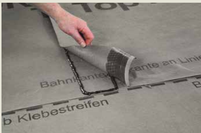
5. Spoj fólií vo zvislom smere sa musí lepiť pomocou lepiacej hmoty. Tá sa nanáša 1 až 2 cm od okraja fólie, pričom samotné preloženie je min. 12 cm.
