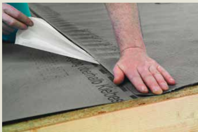
4. Spájanie dvoch fólií v ploche pomocou dvoch integrovaných lepiacich pásov na fólii.
