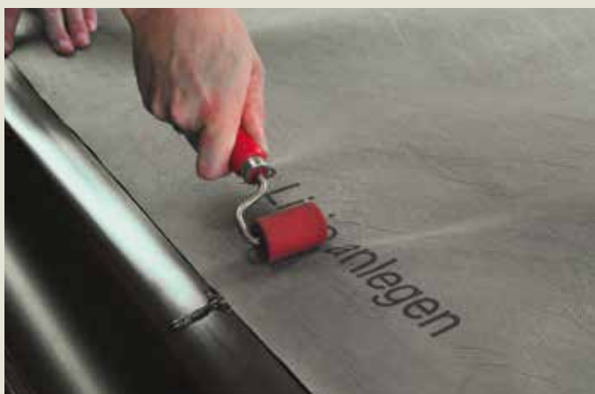
3. Lepenie fólie na odkvapový plech.
