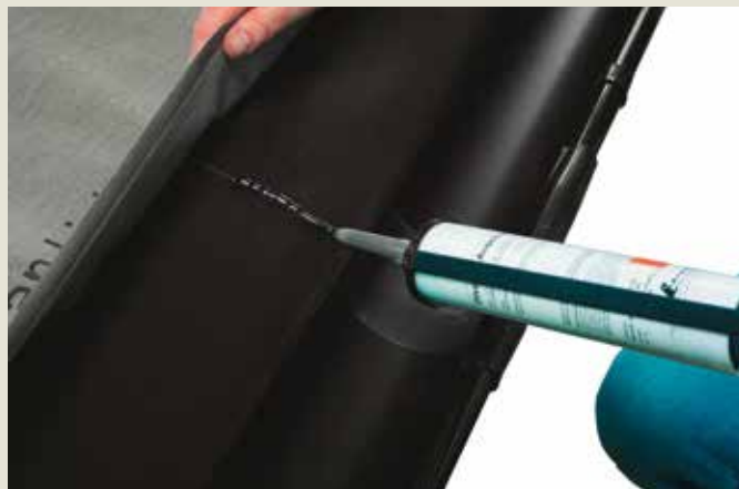
2. Položenie pásu fólie na odkvapový plech s prilepením lepiacou páskou a lepiacou hmotou.
