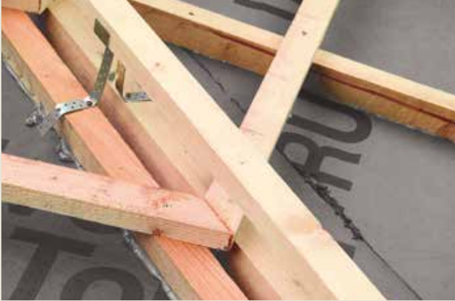
7. Nárožie je vytvorené pomocou dvoch pozdĺžnych kontralát pozdĺž nárožia, ktoré sú utesnené tesniacim tmelom. Na tieto pozdĺžne kontraláty sa prichytáva univerzálny držiak hrebeňovej laty na uchytenie nárožnej laty.
