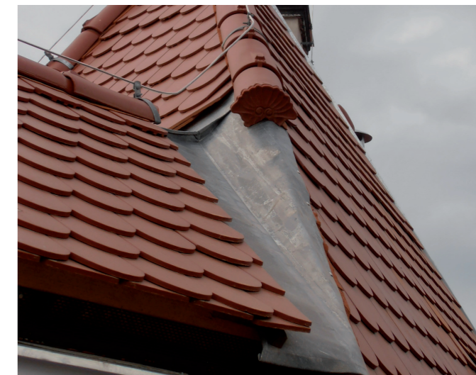
Na ploše 380 m 2 byla použita pálená taška Opál od výrobce Bramac.
