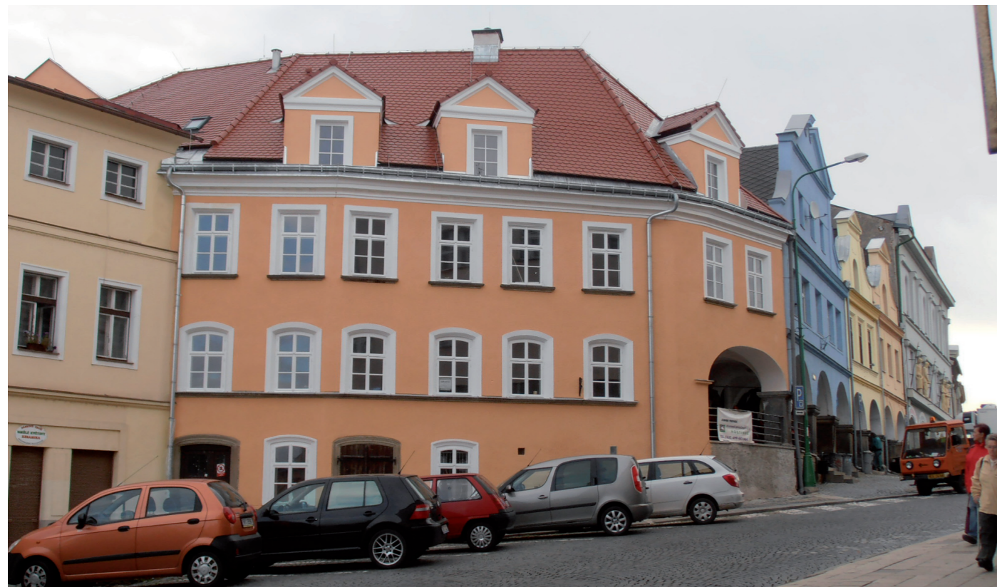
Památkově chráněný dům čp. 40 v centru Jaroměři se dočkal kompletní rekonstrukce: Projekt vypracoval Jiří Kasnar z projekční kanceláře Atrium.
