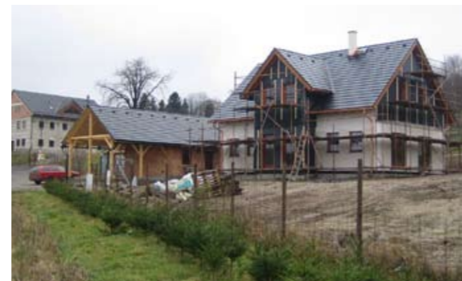
Architektura domu respektuje okolní zástavbu. Jedná se o stavbu s jednoduchou, rovnoramennou sedlovou střechou.
