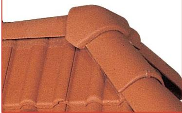
Pro zajištění správné funkce větrané střechy se provádí montáž hřebene a nároží nasucho. Pro odvětrání hřebene a nároží se používá větrací pás Metalroll, Figaroll, Figaroll Plus nebo Basicroll. Větrací pás hřebene se používá pouze pro odvětrání hřebene. Odvětrávací tašky se umisťují do druhé řady pod hřebenem a slouží k odvětrání vzduchové vrstvy mezi krytinou a střešní fólií.
