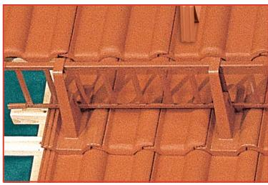
Na střechy objektů přilehlých k veřejným komunikacím či zasahujících nad níže položené konstrukce musí být instalovány zachytávače sněhu. Zachytávače sněhu doporučujeme rovněž umístit nad všechny vstupy a dále na místa, kde dochází k pohybu osob. Tuto funkci v kombinaci s protisněhovými háky plní mrížové sněholamy, trubkové sněholamy či dřevěná kulatina vložená do originálních držáků.
