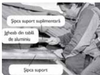
În caz de necesitate montați șipca suplimentară
