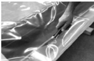
Tăierea foliei și despachetarea colectorului
