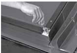
Montarea restului de șuruburi în locația unde au fost cârligele de ancorare
