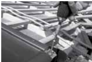
Întotdeauna panoul se fixează cu șuruburi de șipca inferioară
