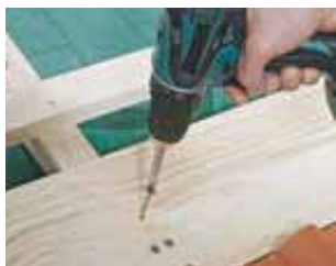
Montajul șipcilor suport
