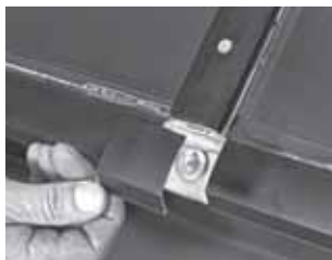
Profilele clips din aluminiu se agață în primă fază în partea inferioară a profilului de aluminiu
