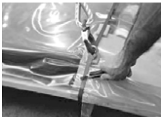
Demontajul ambalajului de pe panoul solar
