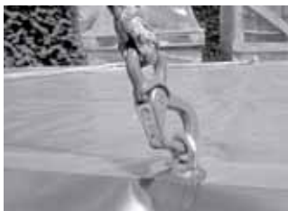
Montajul corzilor pe panou
