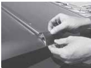
Poziționați cu precizie profilul clips din aluminiu și apăsați în direcția șiciei din aluminiu
