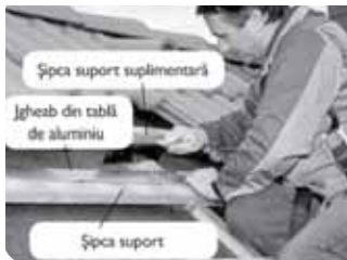
În caz de necesitate montați șipca suplimentară
