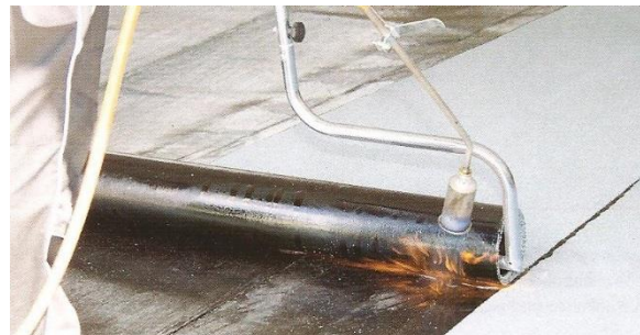
Variantní natavování rozbalovačem rolí
