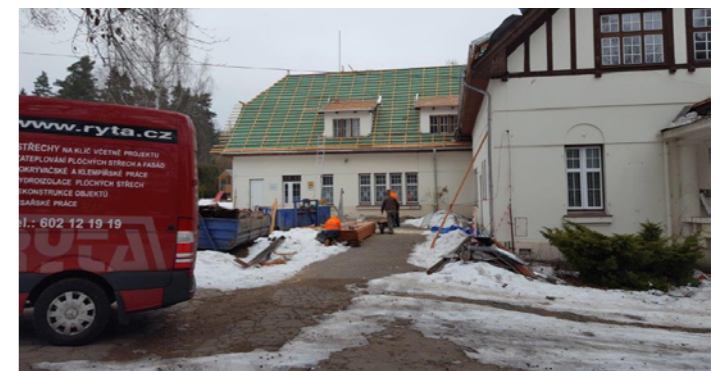
Rekonstrukce probíhala v zimě a kvůli nepříznivému počasí se protáhla na tři měsíce.
