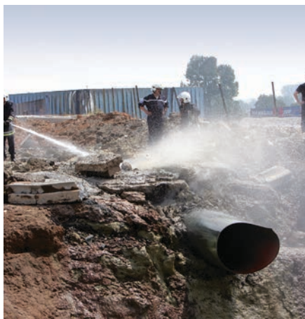
Explosion Ghislenghien : 24 morts, 120 grands brûlés, suite à l'accrochage d'une canalisation de gaz par une pelle mécanique.
