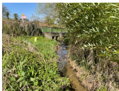
Axe de la canalisation existante le long de la RD 108 avec présence de sols hydromorphes et d'une flore hygrophile herbacée.
