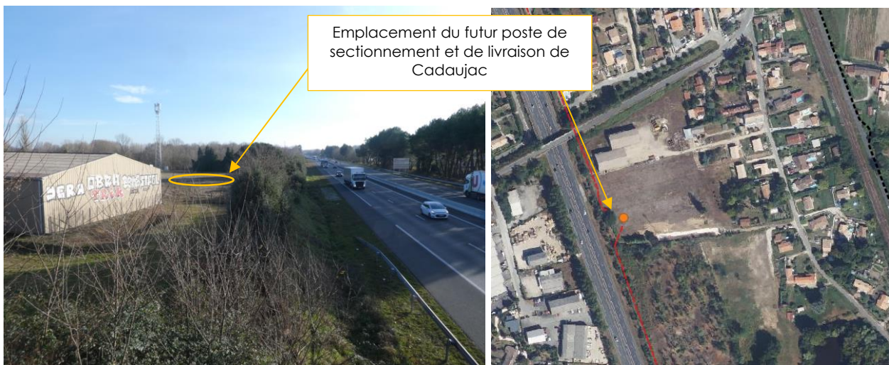
Position du futur poste de sectionnement de Cadaujac -
