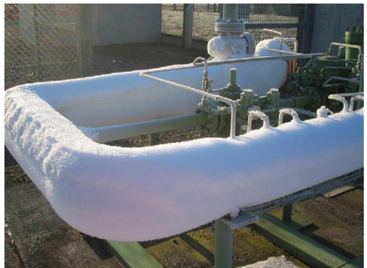
Dépôt de gel sur une canalisation.
