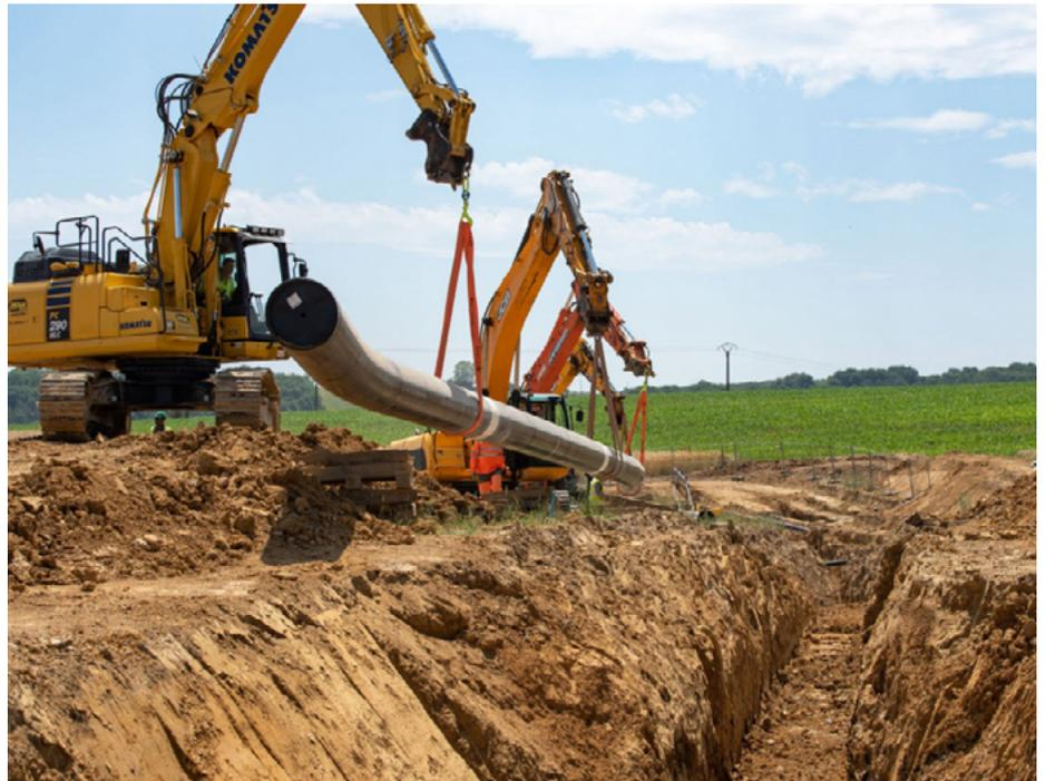
Mise en fouille d'une canalisation sur un chantier.
