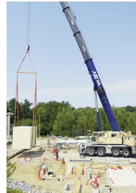
Mise en place de l'édicule technique avant la construction du bâtiment sur la plateforme AGU.
