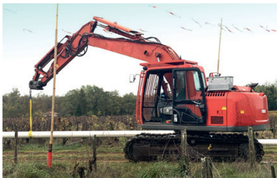
La coactivité homme/engin sur nos chantiers.
