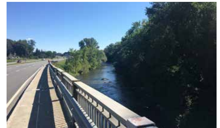
Figure 43 : Pont du Repos, boul. Wilfrid-Hamel
