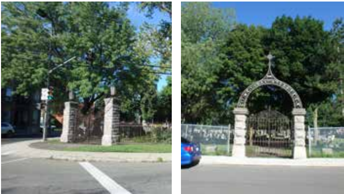
Figure 46 : Portails avenue du Pont-Scott et des Ardennes
