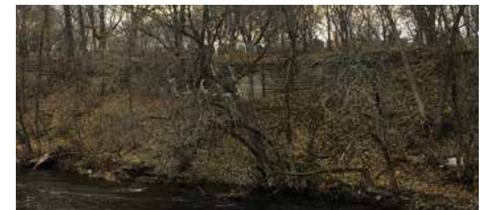
Figure 20 : Structure de stabilisation de la berge
